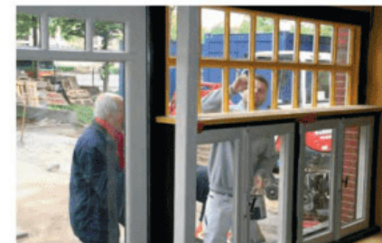
▲ Van Ark voerde het project uit met behulp van een zevental zzp'ers.
